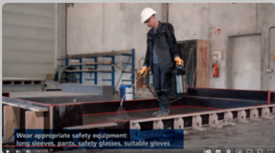
Застосування засобів для розпалубки бетону
